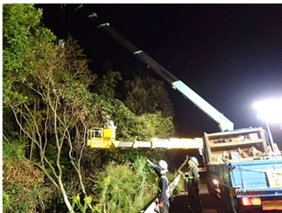
<樹木伐採作業>
