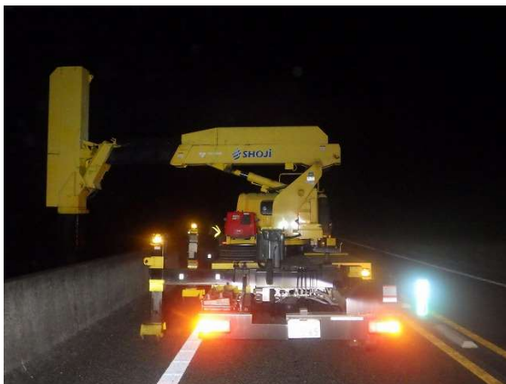
<橋梁詳細点検>
